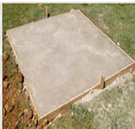
Base pronta para instalação
